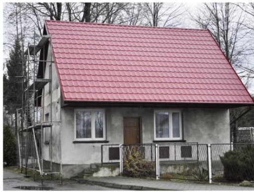
Dach świetlicy KGW w Porębie Wielkiej został wymieniony. Fot. Lech Chodacki
